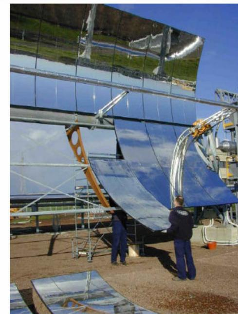
Fig. 16 - Montaggio degli specchi di prima generazione (Powerwall)
