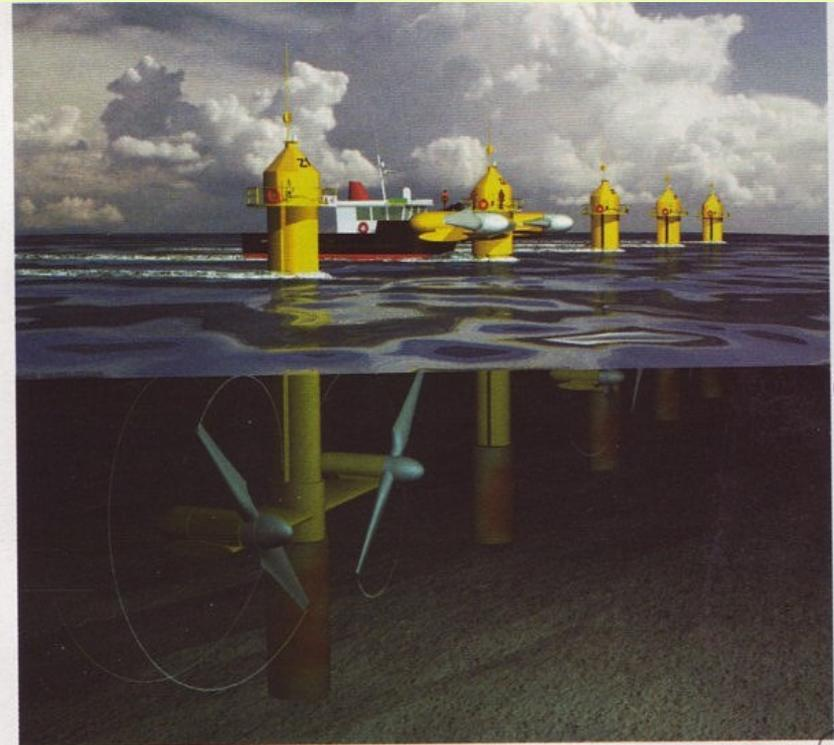
▲ La centrale oceanica progettata dalla Marine Current Turbines è composta da una batteria di turbine disposte a una distanza più ravvicinata rispetto a un analogo impianto eolico. I rotori, ognuno del diametro di 20 metri, si immergono durante il funzionamento, ma possono essere fatti riemergere per la manutenzione.
